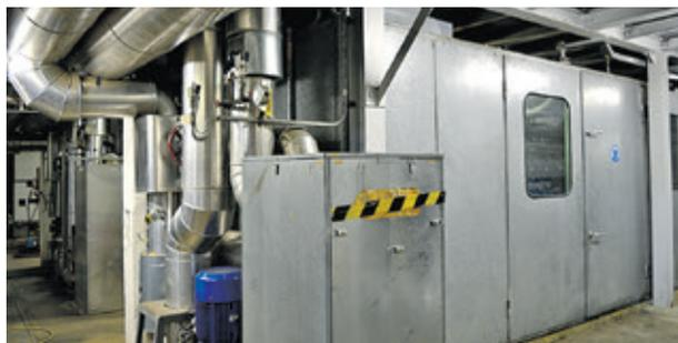
Weil sie so laut sind, haben die Motoren in den Blockheizkraftwerken eine dicke Ummantelung.
